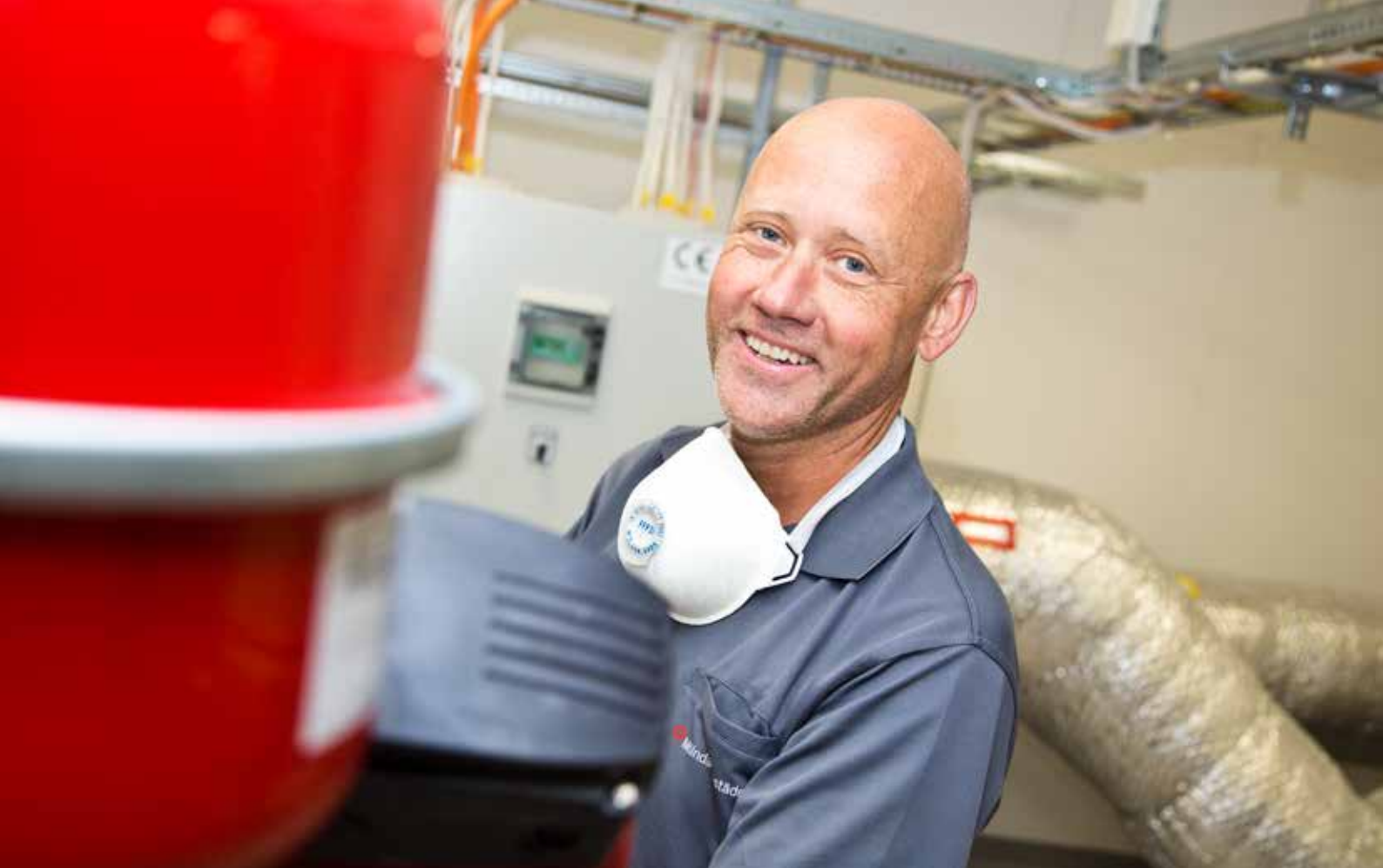
Mats Johnson, drifttekniker, utför ventilationskontroll.
